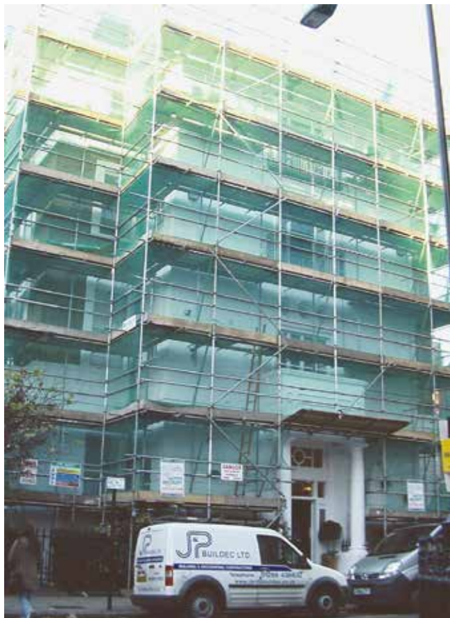
図 10 ロンドンにおける足場 (手すりに加え、中棧、幅木が設置してある)
